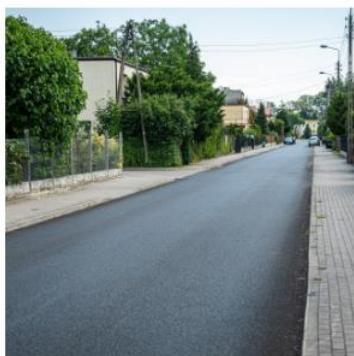
ul. Sienkiewicza po remoncie
