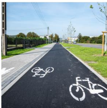
droga rowerowa przy ul. Kosynierów
