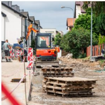
remont ul. Oliwskiej
