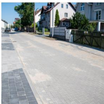
ul. Oliwska po remoncie
