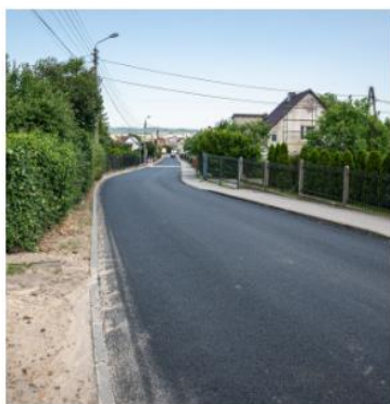
ul. Zbychowskiej po remoncie
